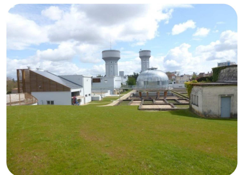
Station de traitement des eaux de Bellejouanne
