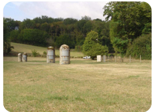
Galerie drainante des sources de Fleury (Lavausseau)
