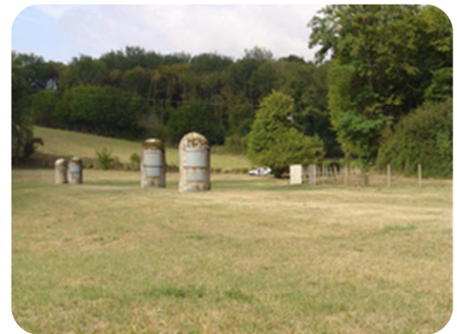
Galerie drainante des sources de Fleury (Lavausseau)
