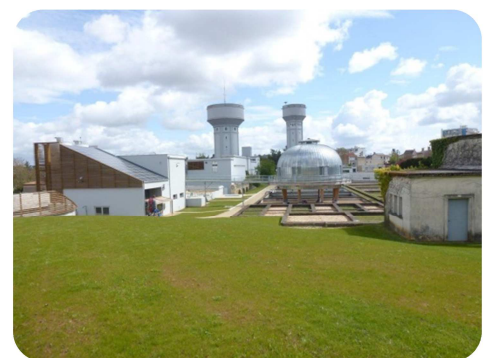
Station de traitement des eaux de Bellejouanne
