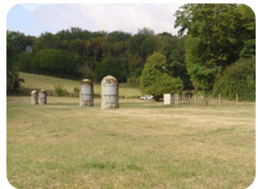
Galerie drainante des sources de Fleury (Lavausseau)
