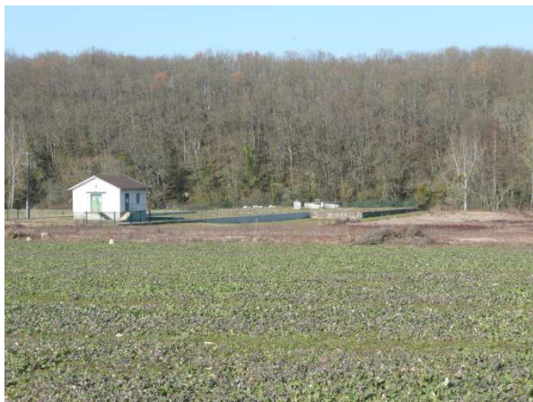
Captage et station de Roche (Jouhet)
